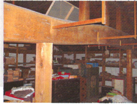
土蔵内部の梁
